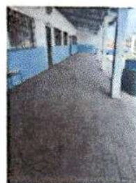
Foto 2: Cambio de piso, por piso cerámico del modulo completo.
